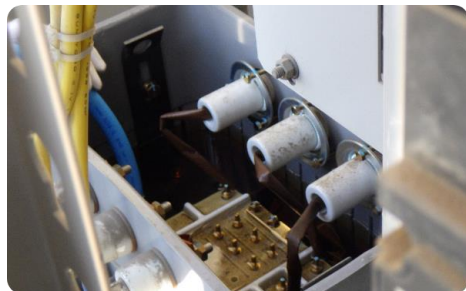
高圧受電設備・環境対応設備の設置
