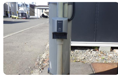
電気自動車用充電設備の設置
