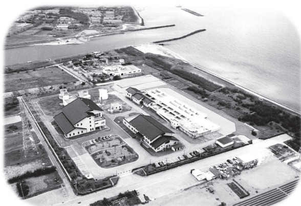
代表的な処理場 国府川浄化センター
