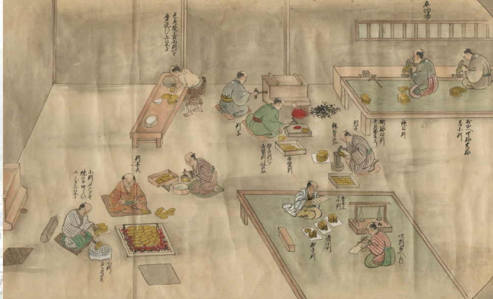
« Rouleau Sado-no-kuni Kanahori-no-maki » Scène représentant la fabrication des pièces koban dans les rouleaux des mines d'or et d'argent de Sado [Collection du musée des traditions d'Aikawa]
