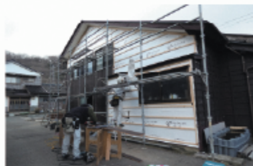
建造物の修理・修景
